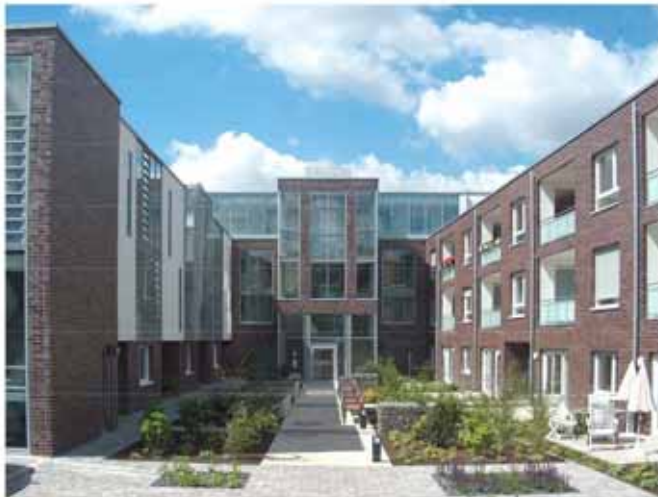
Wohnungsbau - Wohnungswirtschaft Bsp.: Barrierefreie Wohnanlage in Bochum
